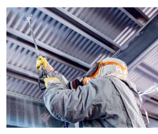
покрытия, она предотвращает прямой контакт между электролитом и сталью, а также адгезии грунтовки к различным подложкам. Готовое покрытие имеет высокие физико-механические и декоративные свойства. Система покрытий позволяет добиться надежной защиты объектов окраски различного предназначения на срок более 25 лет.
