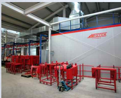
Сушка в конвекционной сушильной камере при температуре 80 °C
