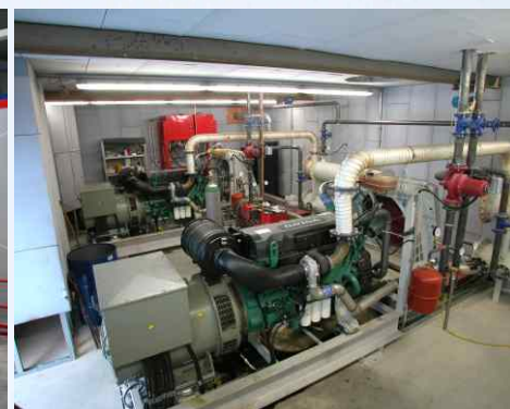
Когенерационная установка с теплообменником выхлопных газов работает на рапсовом масле
