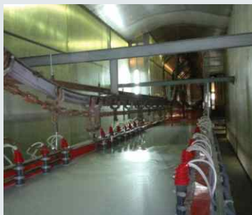
Фото 1 Общий вид цеха
