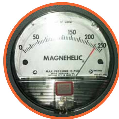
Рисунок 9. Полезный срок службы воздушных фильтров уже давно закончился, и они требуют замены
