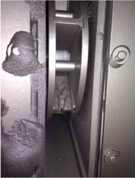
Рисунок 11. Износ лопаток турбин и значительные отложения жирной пыли
