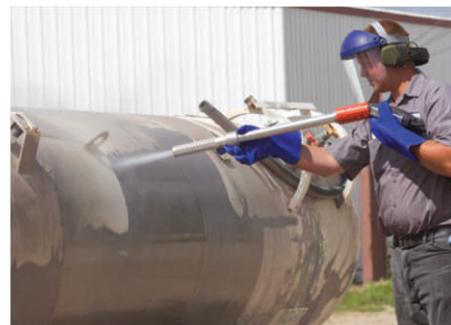
Рис. 7. Видно, что система EсоQuip не создает облако взвешенной пыли, как, например, при абразивоструйной обработке
