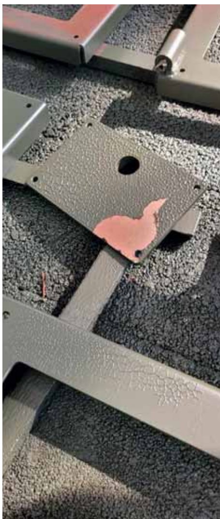
Рисунок 1. Плохая адгезия, отслоение Источник: рисунок автора
