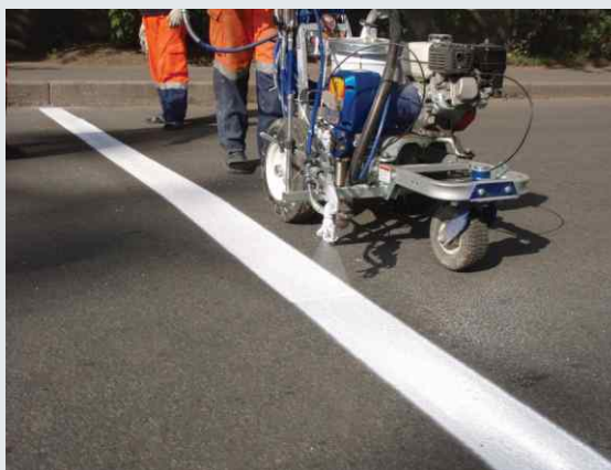
Фото 1 Применение краски на основе винилированного алкида при нанесении дорожной разметки
