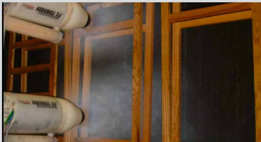
Фото 7. Окраска деревянных рам
