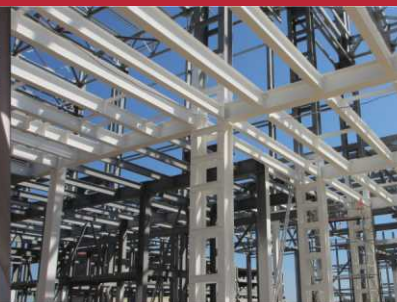
Рис. 4. Система «УХРА 1503 + ВУП-2», г. Саратов, Автосалон Mercedes-Benz, эксплуатация 5 лет
