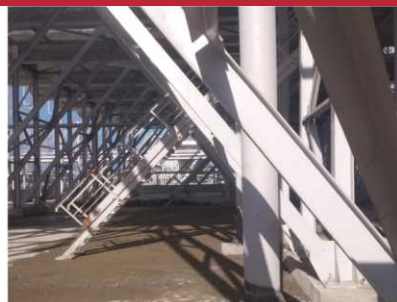
Рис. 3. Система «HEMPAQUICK PRIMER 13624 + НЕОФЛЭЙМ® 514 Р + HEMPATHANE HS 55610», Ленинградская обл., г. Усть-Луга, Морской торговый порт, 2 года эксплуатации в атмосферных условиях
