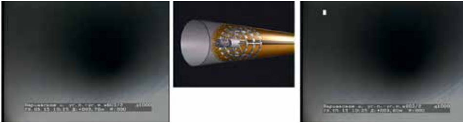
Рисунок 5. Нанесение минерально-полимерного покрытия на внутреннюю поверхность стального трубопровода с помощью центробежной распылительной головки
