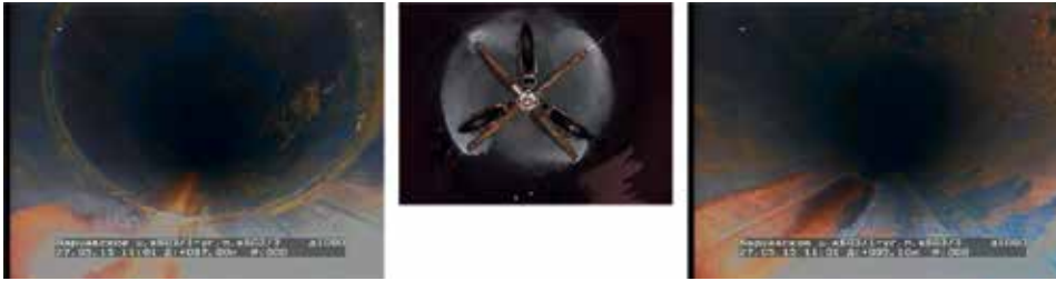
Рисунок 4. Внутренняя поверхность трубопровода после проведения гидродинамической чистки
