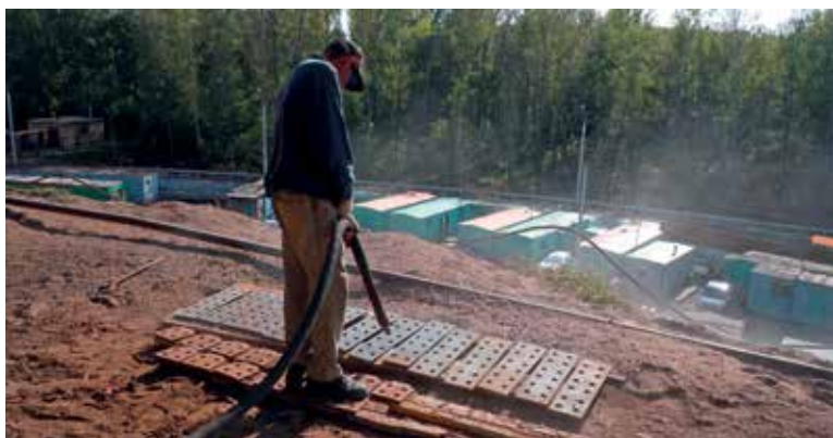
Рис. 1. Необходимо проводить струйную подготовку поверхности накладок и стыков до сборки стыковочного узла для обеспечения нужного коэффициента трения контактных поверхностей фрикционного соединения
