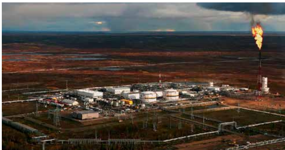
Материалы ВМП защищают от коррозии объекты Ванкорского месторождения компании «Роснефть»
