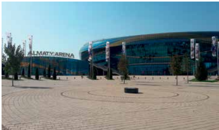
Металлоконструкции Ледового дворца в Алматы (Казахстан) покрыты огнезащитными материалами ВМП
