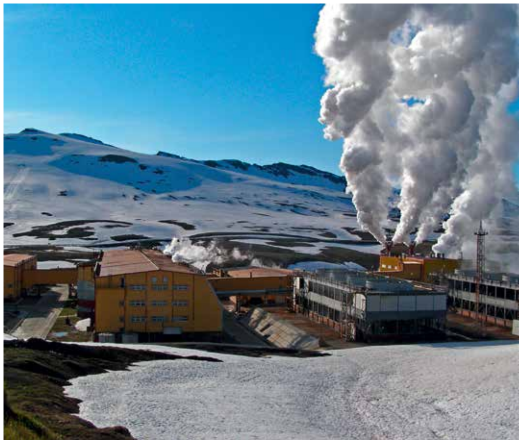
Металлоконструкции Мутновской геотермальной электростанции окрашены покрытиями ВМП в 2001 г.
