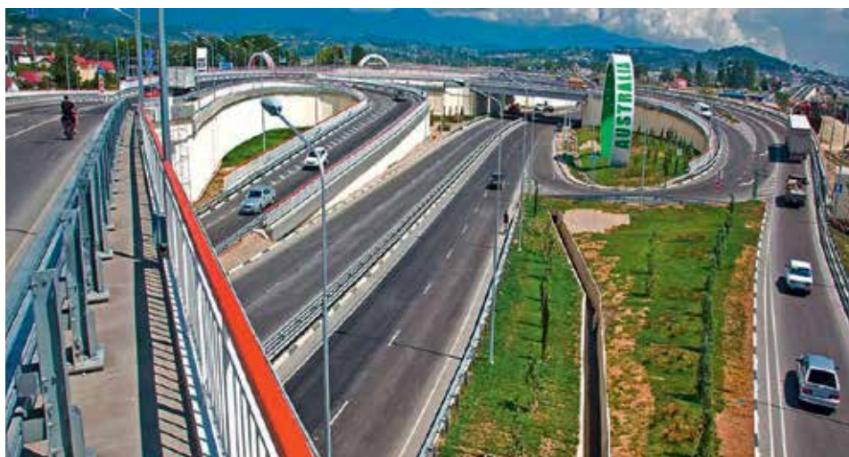
Покрытия ВМП защищают металлические и железобетонные конструкции транспортной развязки «Адлерское кольцо» в г. Сочи
