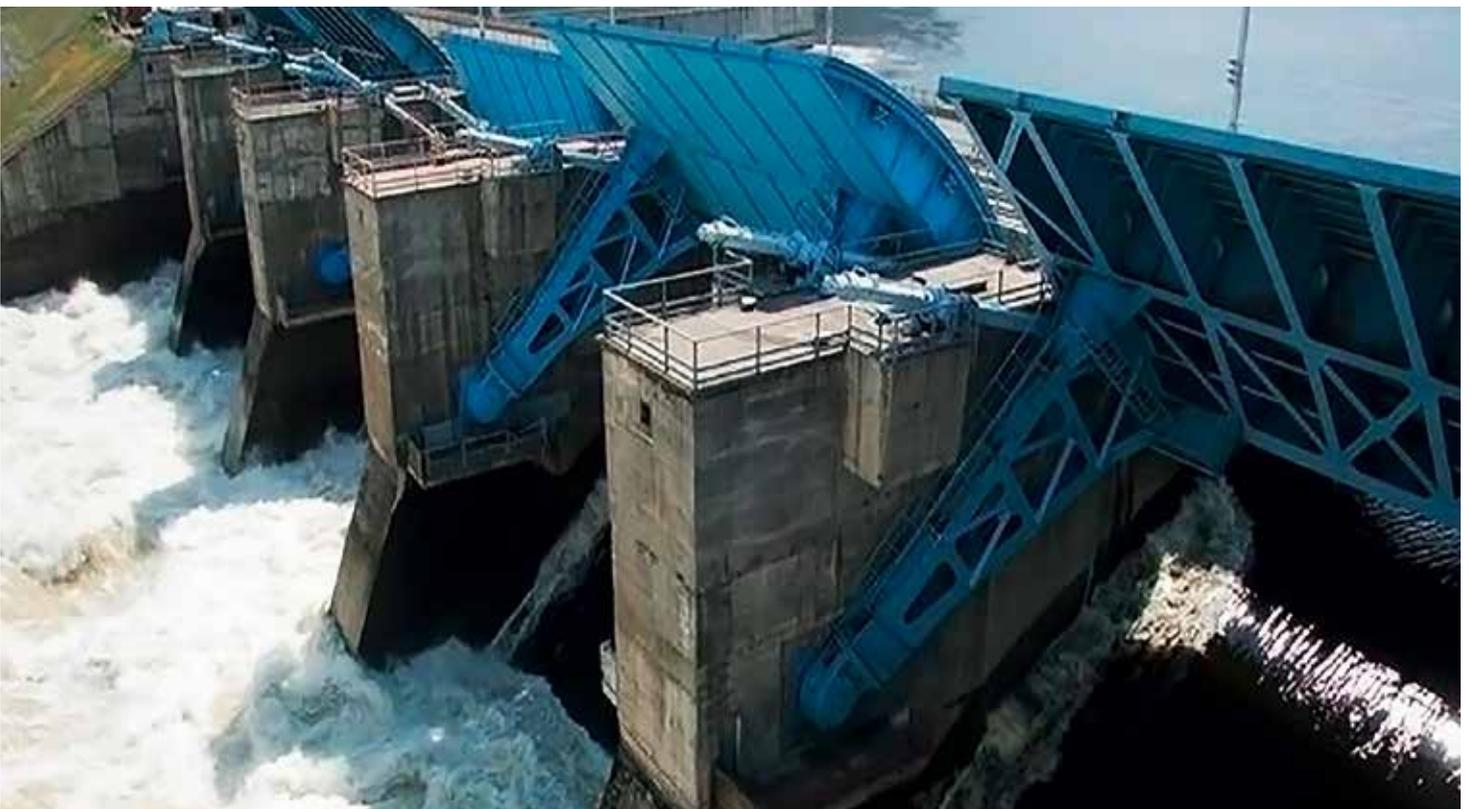
Рис. 6. Гидрозатворы Майнской ГЭС окрашены противообледенительной эмалью ЭП-439П
