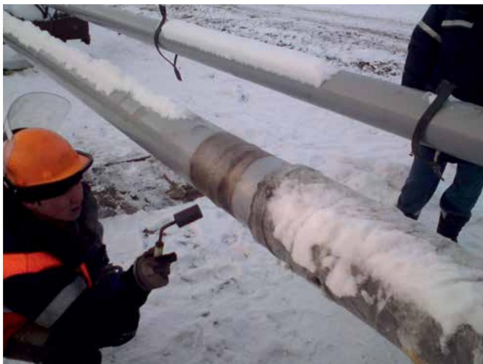
**Рис. 4.** Нанесение ремонтного состава ДПК на месторождении «Варандейнефтегазстрой», п. Харьяга, Ненецкий автономный округ. Температура окружающего воздуха минус 15 °С
